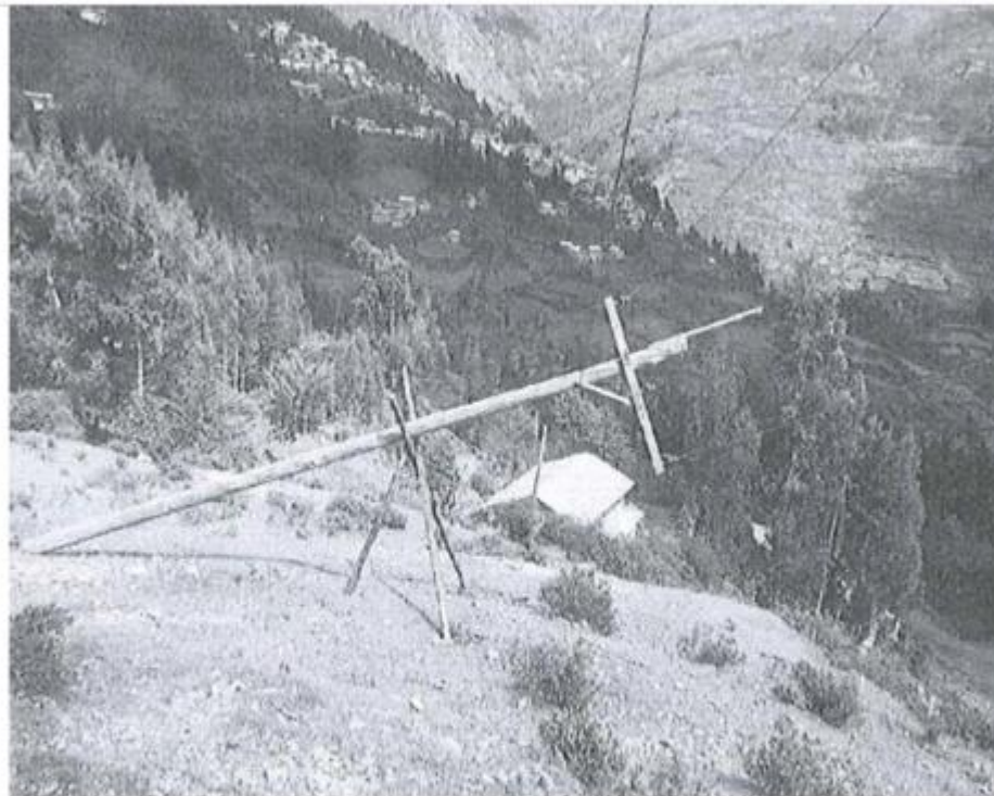
Se puede apreciar muchas estructuras como esta en el AMT 4954 existente, los cuales requieren su mejoramiento, por haber cumplido su vida útil.
